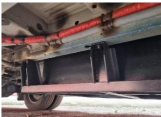
Attēls Nr.10-11. Dienvidkurzemes novada pašvaldības mikroautobusa instalācijas risinājumi un baterijas
